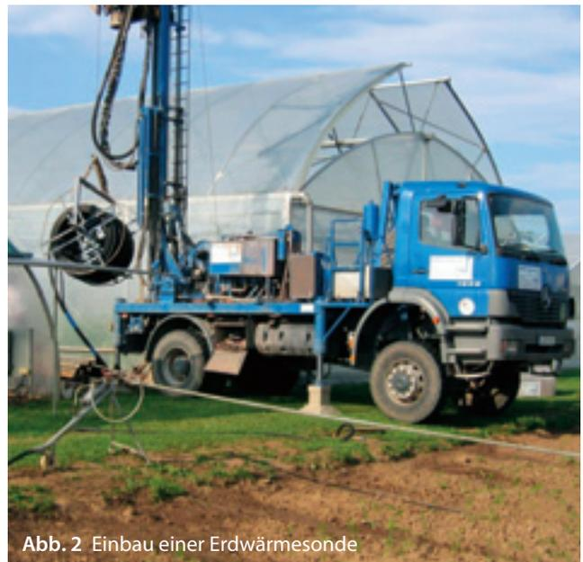
Abb. 2 Einbau einer Erdwärmesonde
